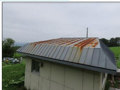
配水施設(管理棟)
