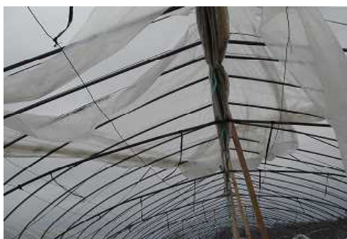
写真14 被覆資材を切断
