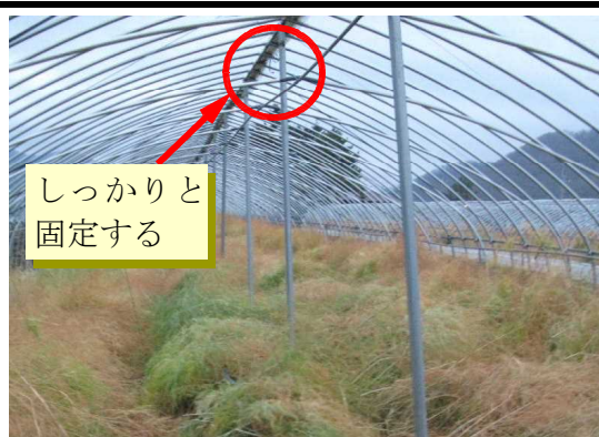
写真5 中柱の設置
