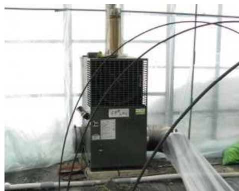
写真6 ボイラーを準備
