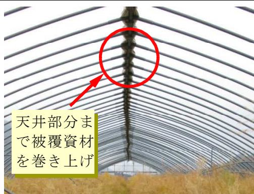
写真4 資材の巻き上げ
