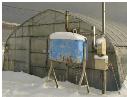
写真8 燃料タンクを確認
