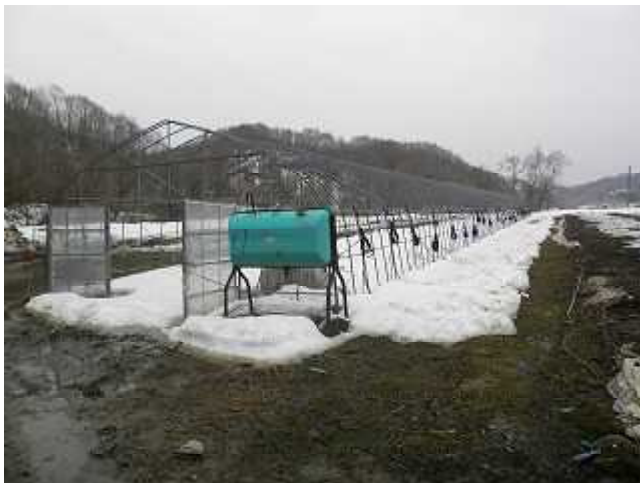
写真4 冬期間、ビニールを除去しており、被害を 免れた。
