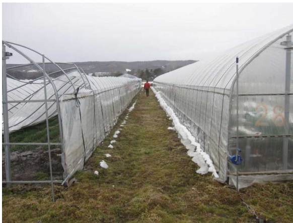
写真4 ハウス同士の間隔は220～250cmほどあり、屋根からの落雪が確保できるスペースが十分にあった。
