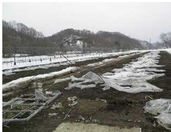
写真1 山側から始まったハウス倒壊 (撮影：H30年3月14日)
