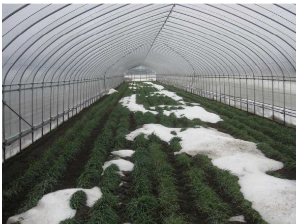
写真5 倒壊しなかったハウス内部。 雪は被災後に通路からハウス内に除雪したものが撮影時にも残っていた状態。
