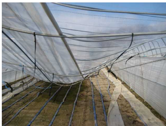
写真1 ハウスの半分より奥が半壊した (撮影 H30年3月16日)
