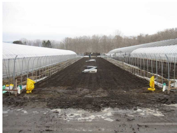
写真1 倒壊ハウス跡
