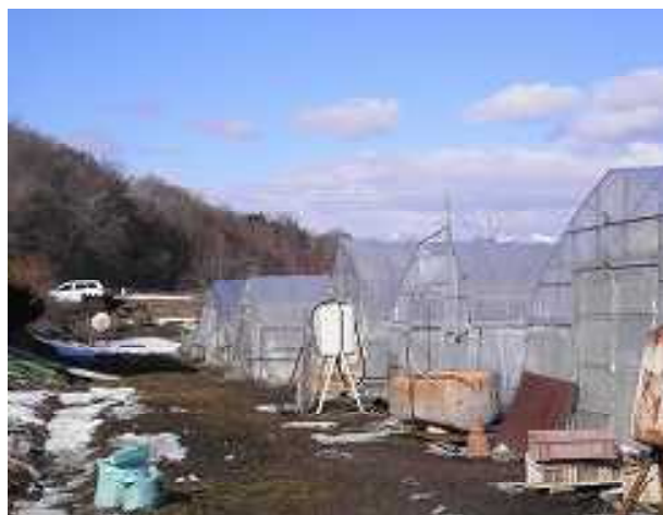
写真1 ゆがみのあったハウスが倒壊 (撮影：H30年3月13日)
