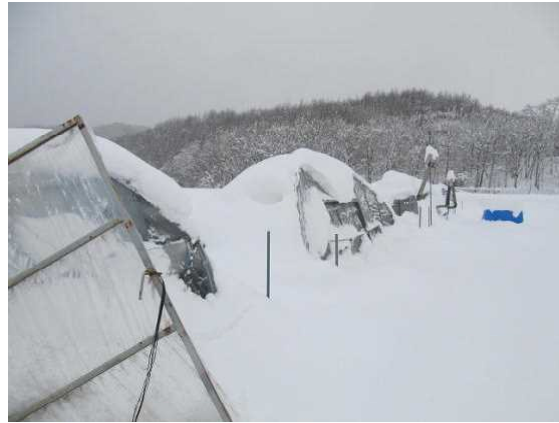
写真10：2月6日 静内東別 ハウス倒壊
