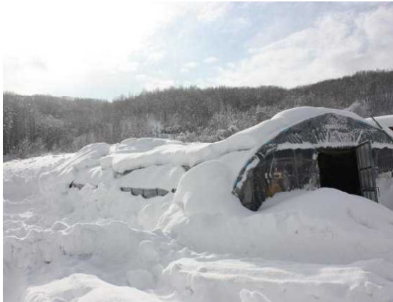
写真9：2月6日 静内東別 ハウス倒壊
