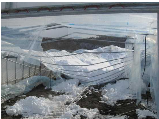
写真13：2月6日 静内田原 倒壊ハウス内部
