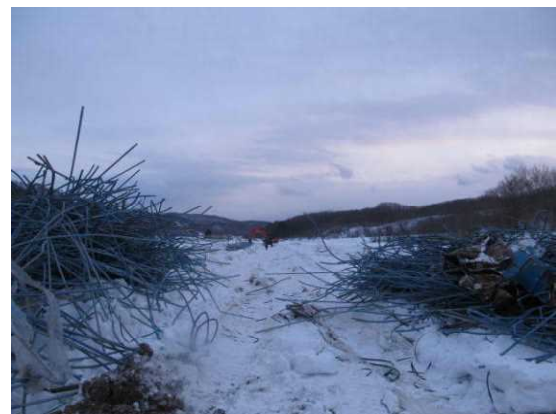
写真18：2月19日静内東別 撤去されたハウスの鉄骨
