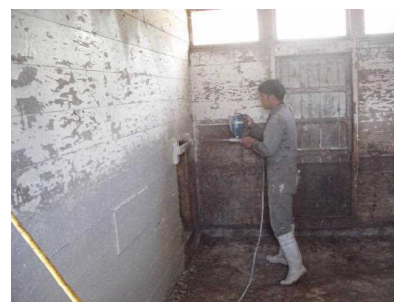
写真5 石灰塗布の実施
