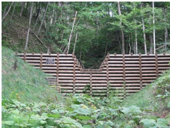
【保安林内に設置した木製治山ダム】
