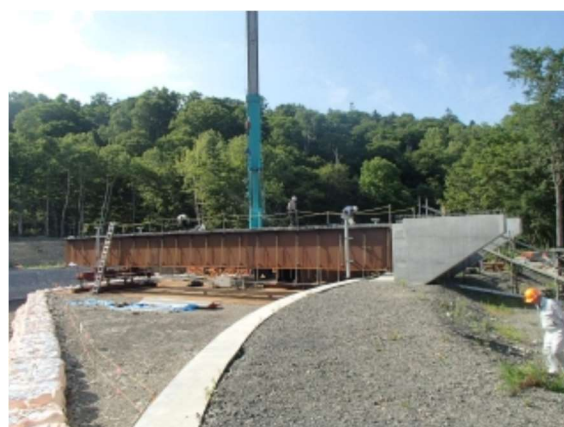
【林道の橋梁架け替え工事】
