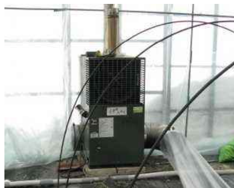
写真6 ボイラーを準備
