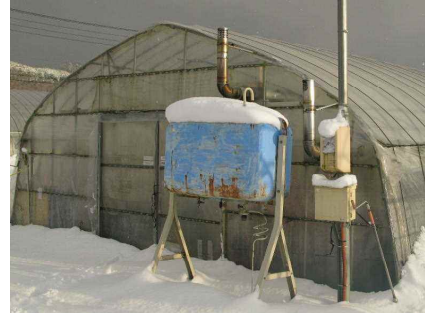
写真8 燃料タンクを確認
