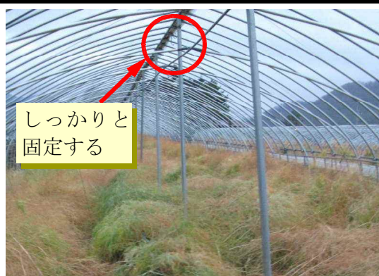
写真5 中柱の設置
