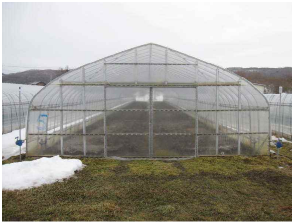
写真3 作物が作付けされていないハウスでは倒壊を免れた。
