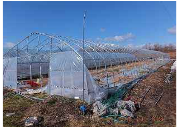
写真1 再建中のハウス
