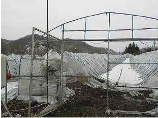
写真2 山側より倒壊が始まりビニールを 展張していたハウスは全棟倒壊と なった。
