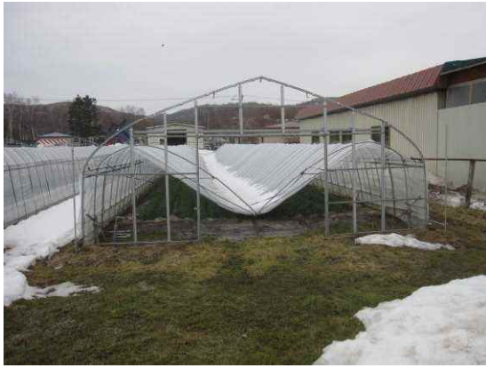
写真15：3月13日 静内田原 妻面ビニール除去したハウス
