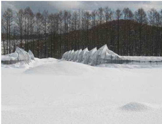
写真3：2月6日 新冠町明和 ハウス倒壊 外観
