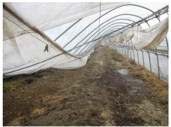
写真14：2月6日 静内川合 倒壊ハウス内部
