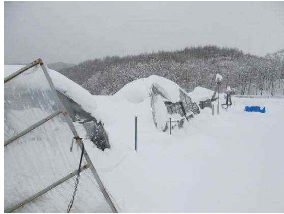
写真10：2月6日 静内東別 ハウス倒壊
