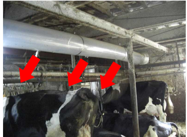
写真2 ダクトファンの稼働状況
