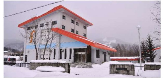
日高町日高浄化センター
