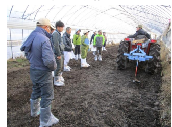
カットドレーンminiの施工
