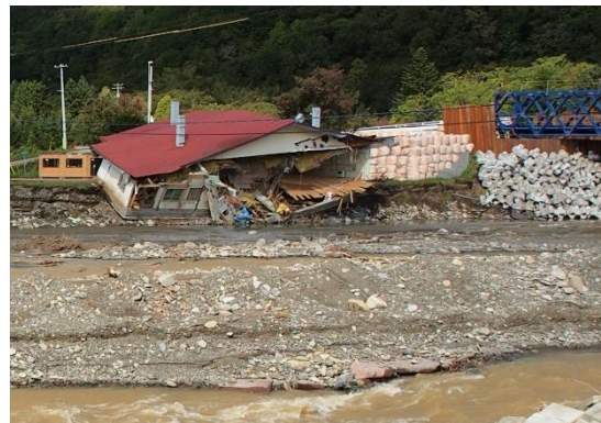
沙流川の氾濫により全壊した日高町千栄生活館
