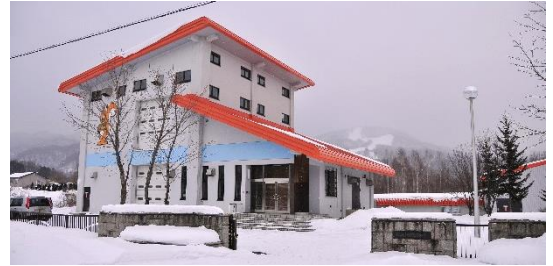
日高町日高浄化センター
