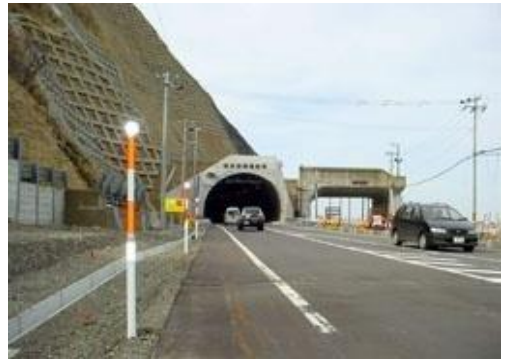
一般国道336号襟広防災(えりも黄金トンネル)
