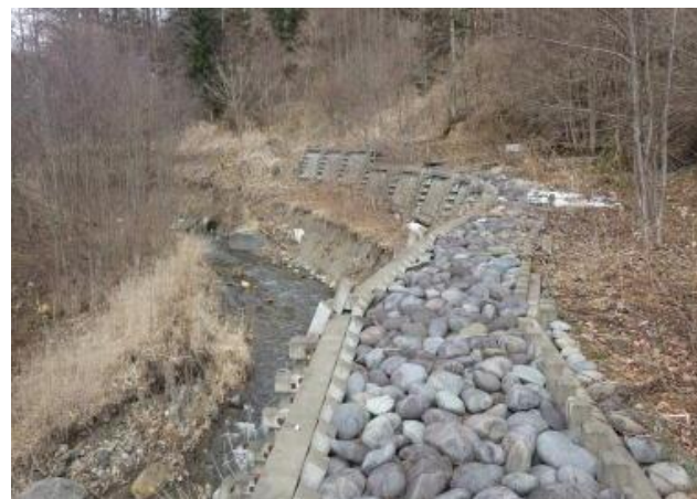
図2. 溪流護岸工イメージ
