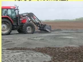
地盤整備（石炭灰使用）
